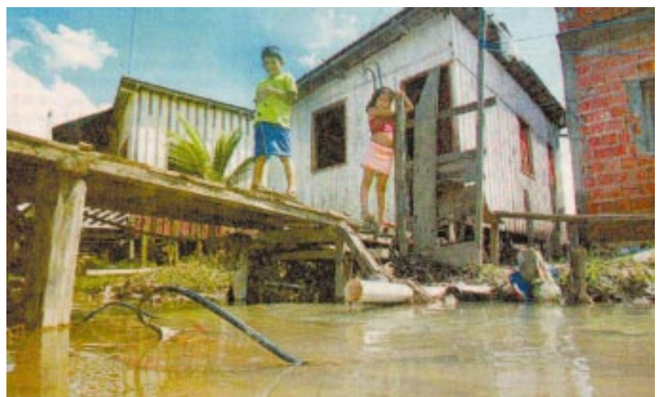
ESGOTO A CÉU ABERTO NO IGARAPÉ DOS FRANCESES, REGIÃO CENTRO-OESTE DE MANAUS
